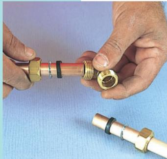
**3. Enfoncer le tube dans le raccord jusqu'à la butée d'arrêt.**
