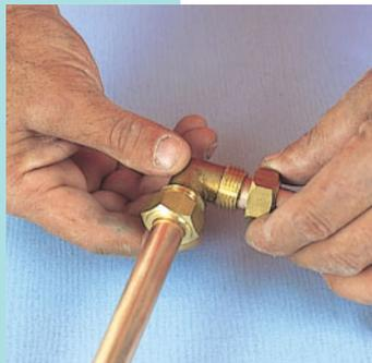
**4. Pousser le joint et le collet mobile contre le raccord et visser l'écrou à la main.**
